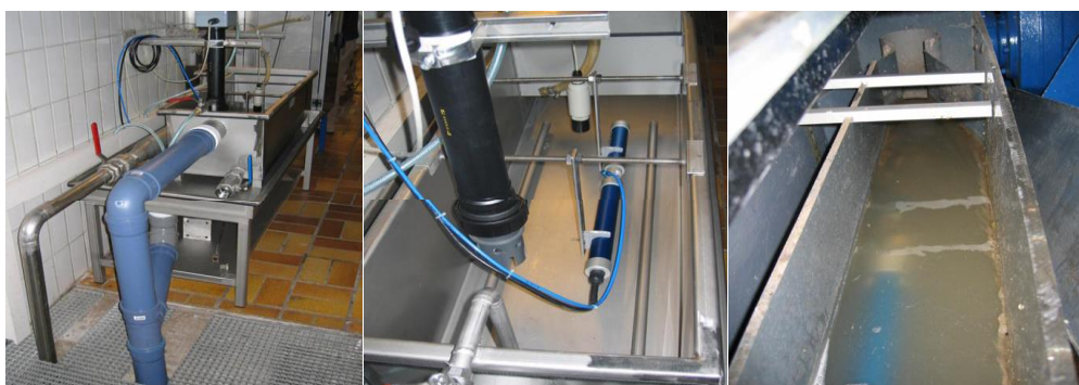
Rys. 1. Lokalizacja sond on-line firmy S-can umieszczonych na pływaku (pontonie) w burzowcu w systemie kanalizacji ogólnospławnej w Grazu [1, 2]
