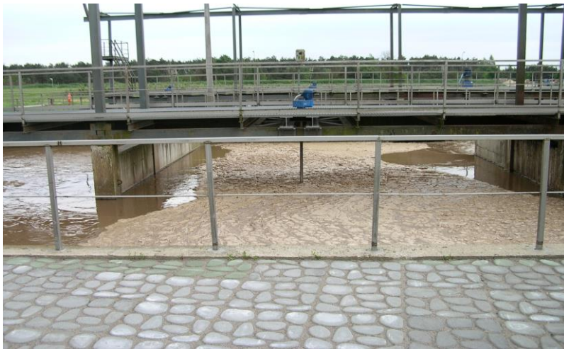
Rys. 5. Komora denitryfikacji z mieszadłem wolnoobrotowym
