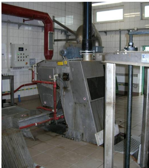
Rys. 3. Krata mechaniczna Aqua Screen KLRV-03
