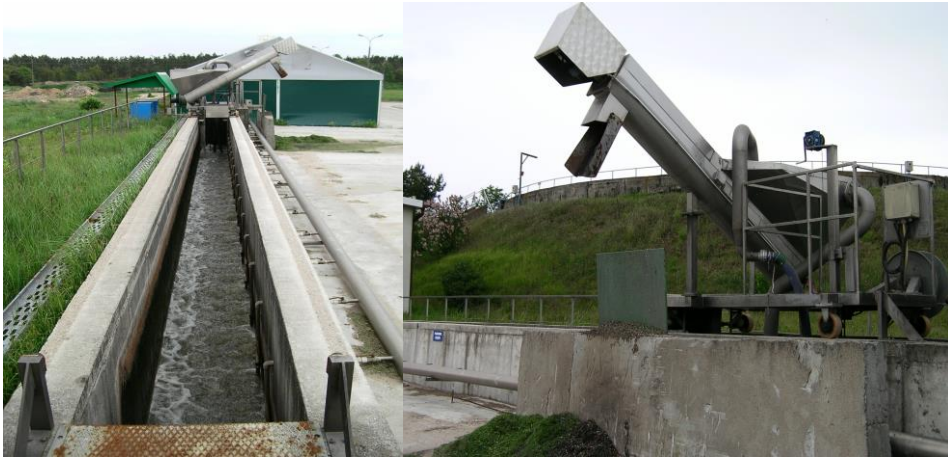
Rys. 4. Piaskownik poziomy
