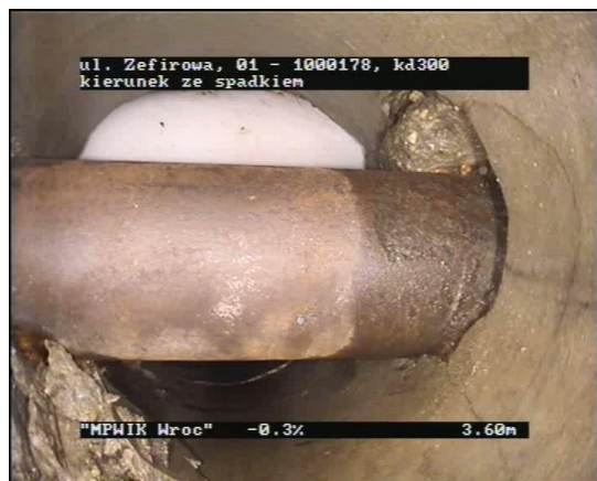
Rys. 4. Przecisk w istniejącym kanale [13]
