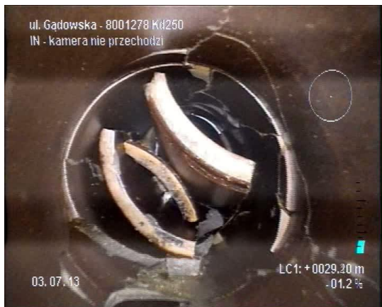
Rys. 5. Zator z połamanej kamionki [13]
