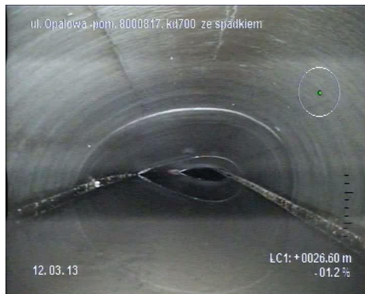
Rys. 3. Zgnieciony kanał [13]
