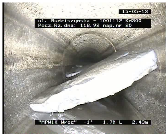
Rys. 7. Beton w kanale [13]
