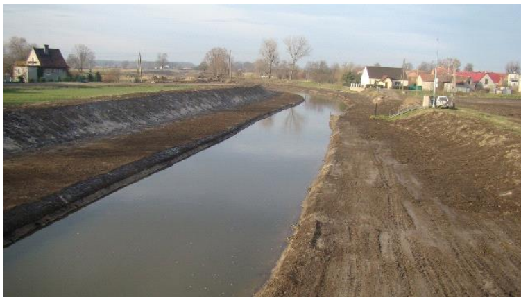
Fot. 2. Widok na koryto Orli w przekroju Korzeńsko po regulacji w listopadzie 2013r. Widok w dół rzeki pomiędzy mostem drogowym a przekrojem wodowskazowym. Fot. V. Dumbur, K. Wójcik
