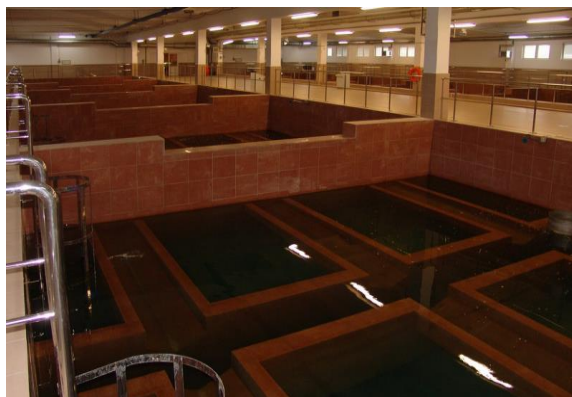
Rys. 3. Filtry grawitacyjne pospieszne w SUW Pietrasze [13]
