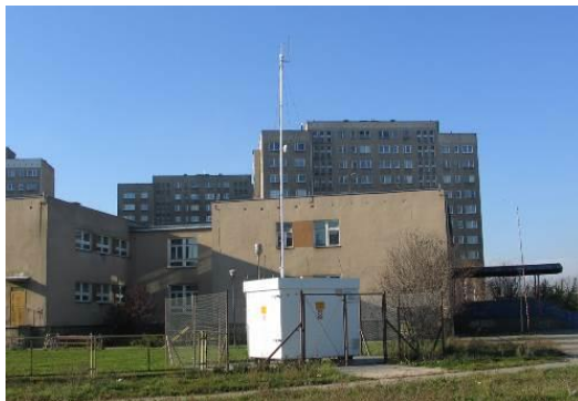
Fot. 1. Stacja monitoringu powietrza w Pile (autor: B. Gruchociak)
