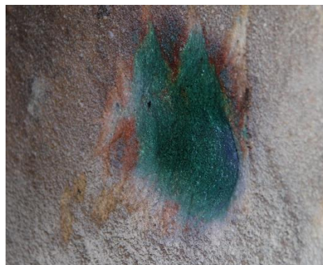
Rys. 10. Pomiar wartości pH przed oczyszczeniem Rys. 11. Pomiar wartości pH po oczyszczeniu
