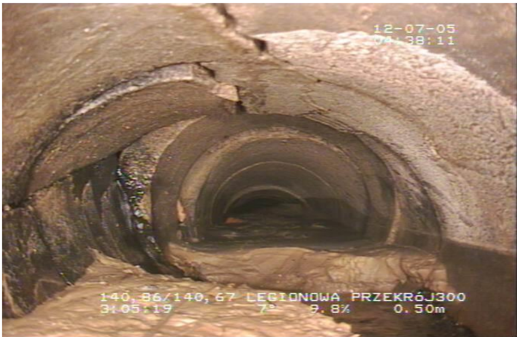
Rys. 5. Składanie się kanału betonowego
