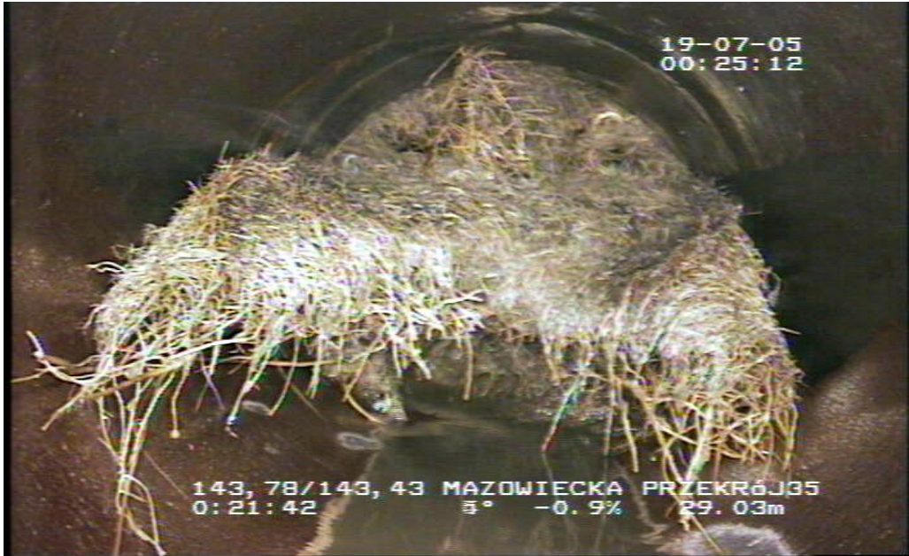
Rys. 4. Zarastanie kanału przez korzenie
