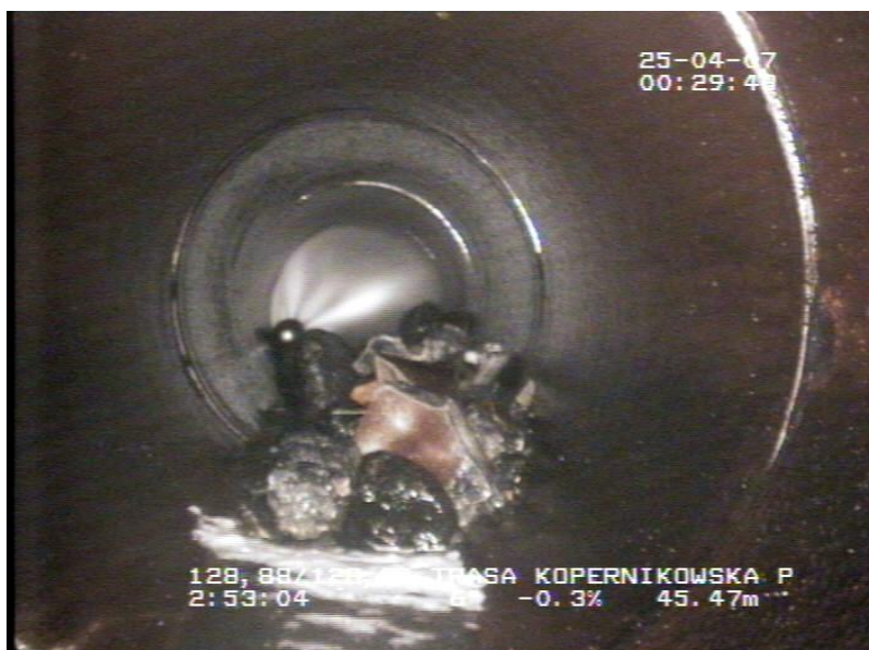
Rys. 8. Czyszczenie kanału
