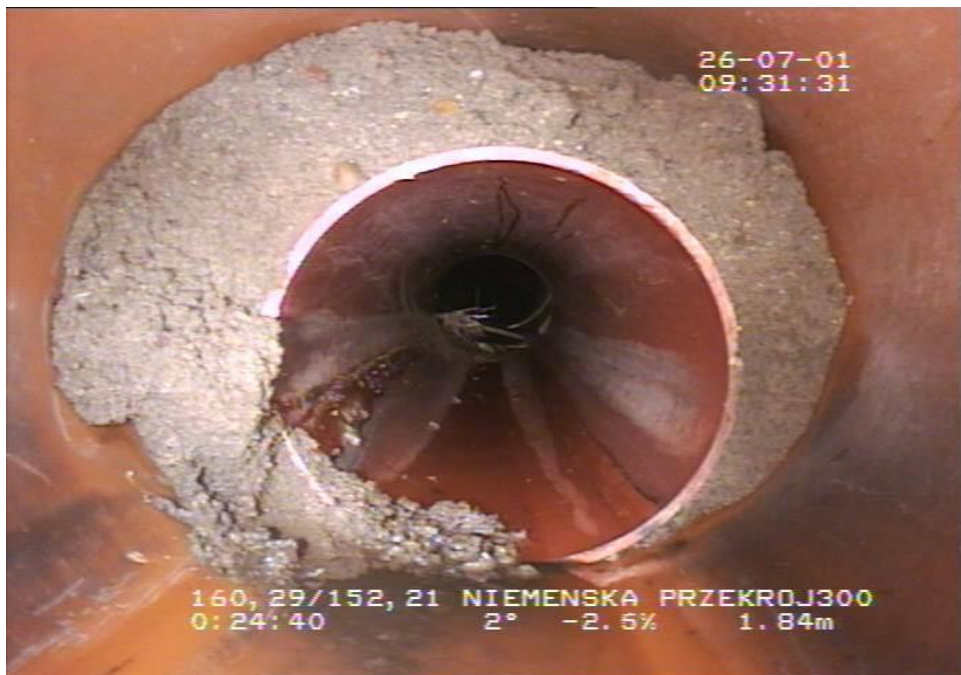
Rys. 12. Zmniejszenie średnicy kanału
