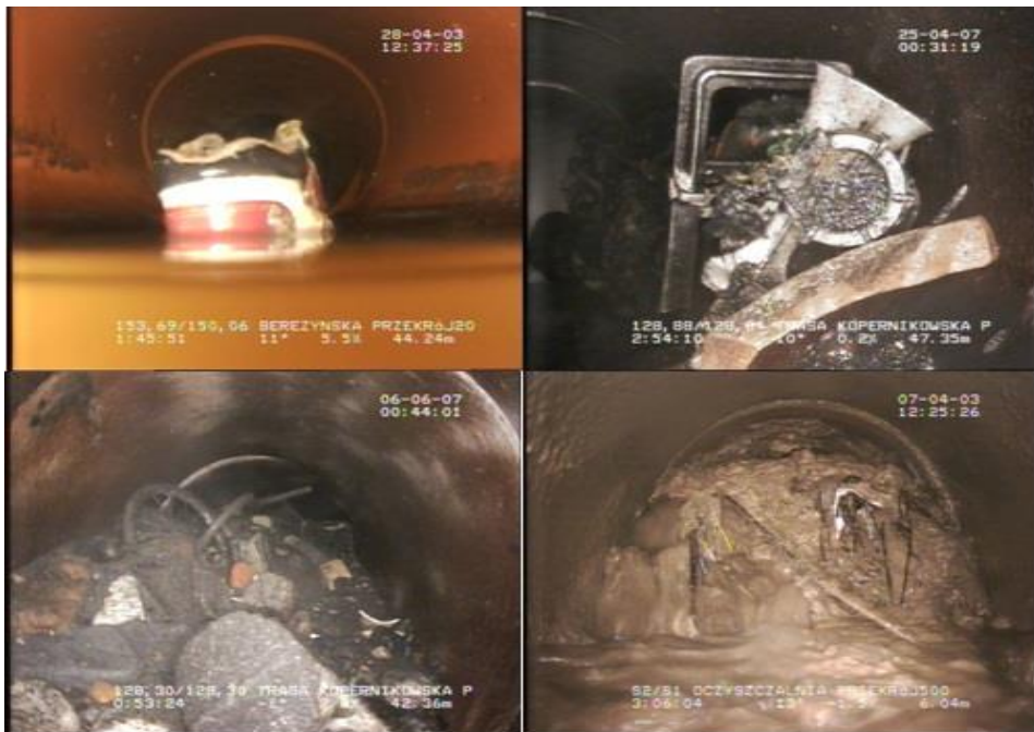
Rys. 6. Zatory w kanałach
