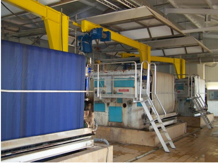
Rys. 3. Prasy w stacji odwadniania osadu
