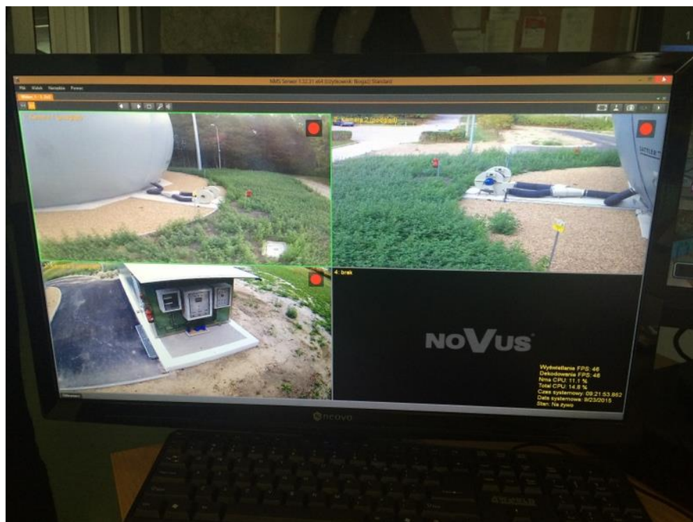
Rys. 4. Obraz z kamer na monitorze w dyspozytorni białostockiej oczyszczalni ścieków
