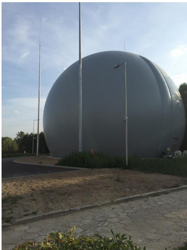
Rys. 3. Sferyczny zbiornik gazu w białostockiej oczyszczalni ścieków
