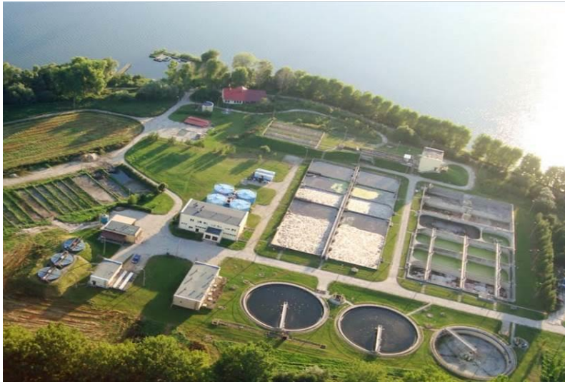
Rys. 3. Widok na oczyszczalnię ścieków w Bystrym k. Giżycka [18]
