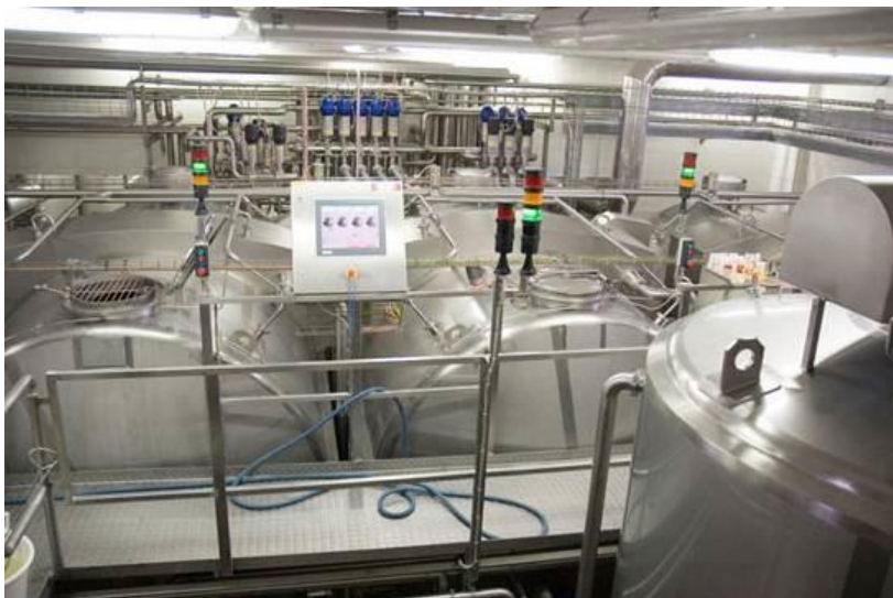
Rys. 2. Widok na odbieralnię mleka w OSM w Giżycku [17]
